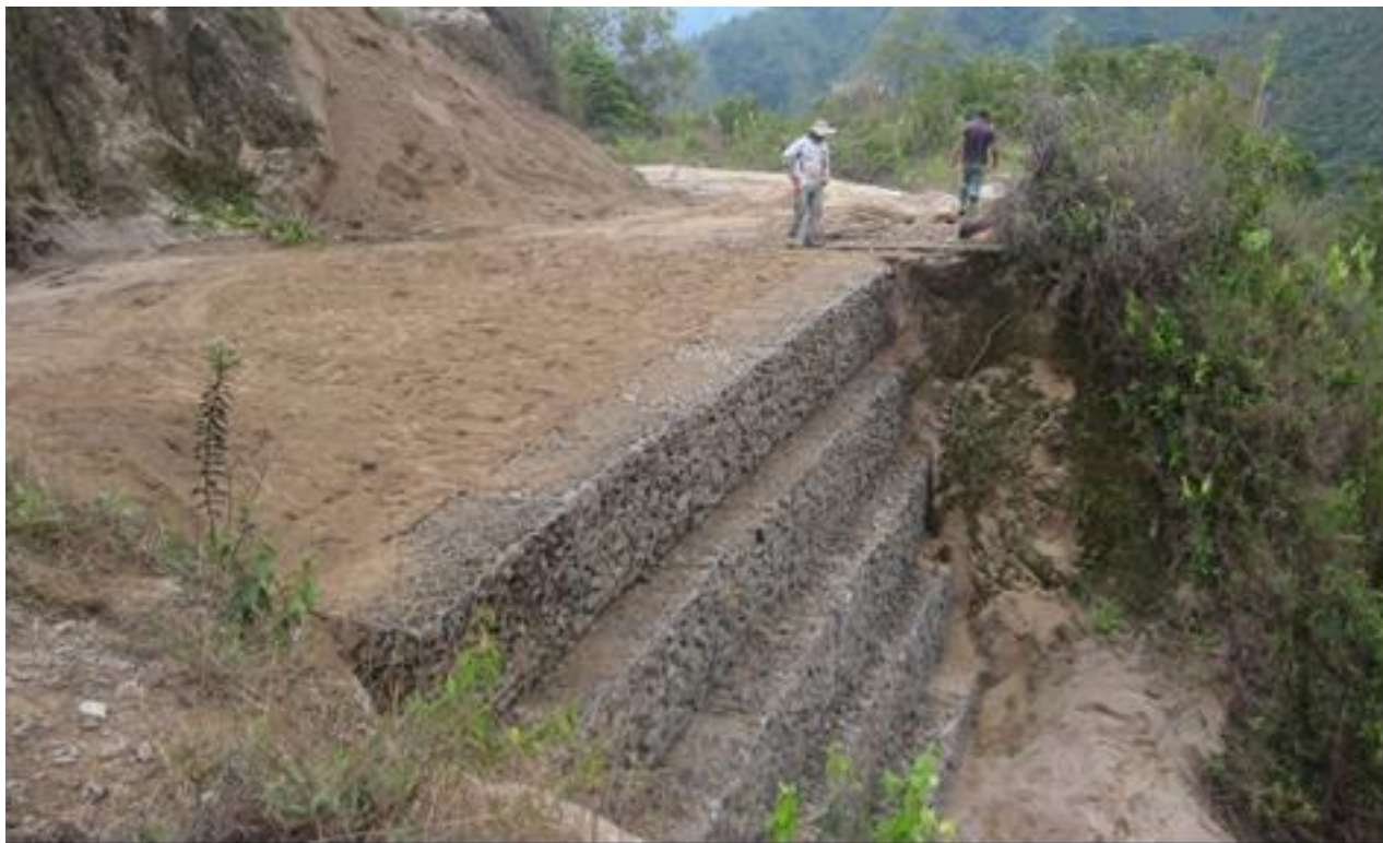
Registro fotográfico de muro de gavión construido en la vía Santa Fe.
