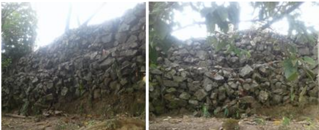
Registro fotográfico de muro de gavión en el casco urbano del municipio de Rioblanco.
